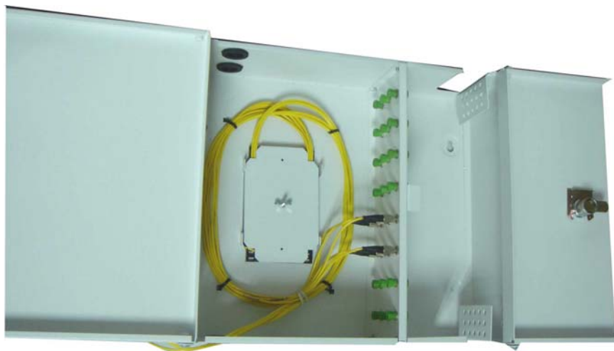
รูปที่ 6 การติดตั้งสาย Pigtail
