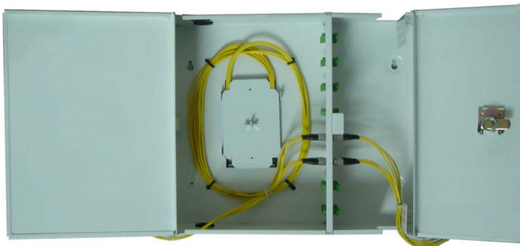
รูปที่ 7 การติดตั้งสาย Patchcords
