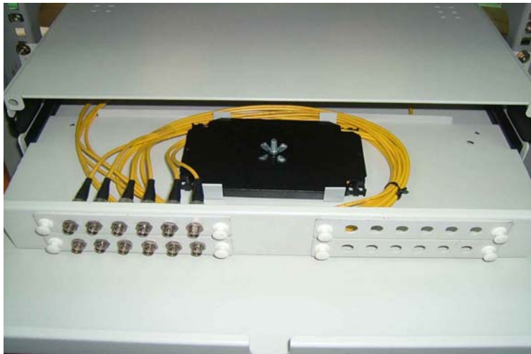
รูปที่ 7 การติดตั้งสาย Patchcords
