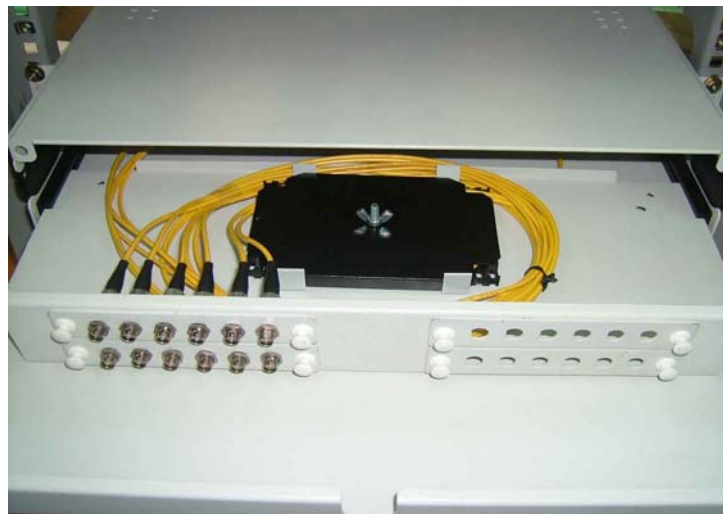
รูปที่ 6 การติดตั้งสาย Pigtail
